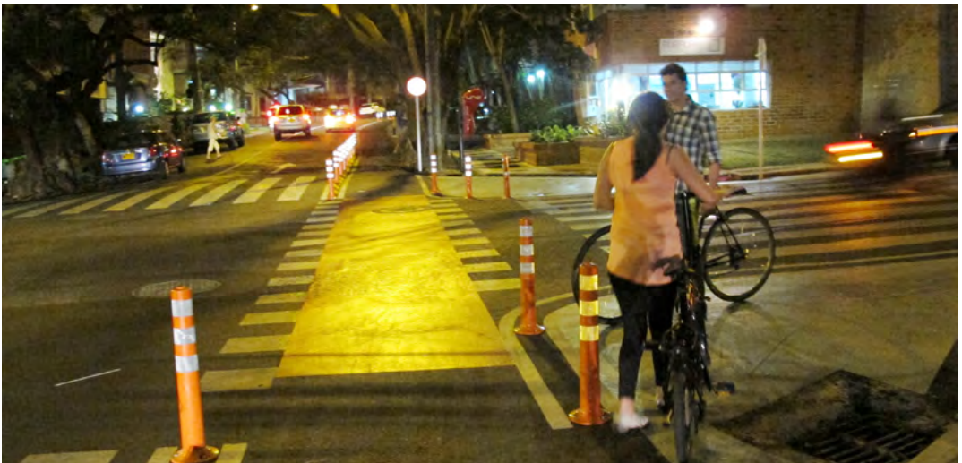
Foto 38. Solución de paso para ciclistas en una intersección con el refuerzo cromático de la zona de cruce (Medellín)
