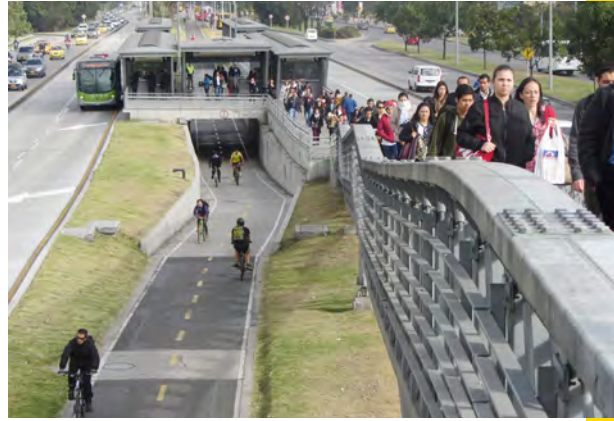
Foto 35. Túnel ciclista cerca de sistema de transporte masivo-Bogotá
